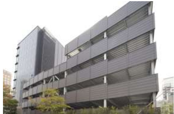
自走式立体駐車場
