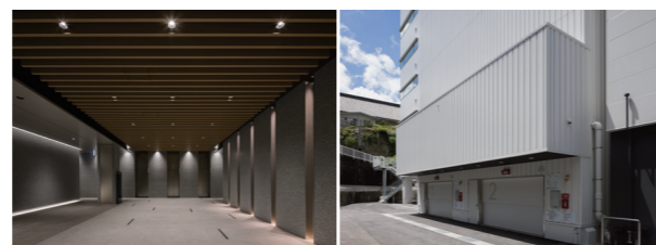
1階エントランスホール正面
