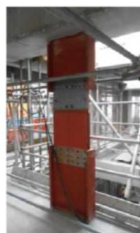
制振ダンパー配置イメージ
